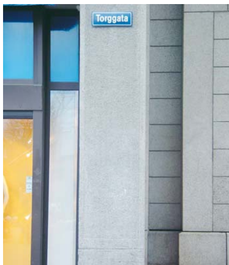
Profilert overflate hvor rillene er hugget etter herding.
