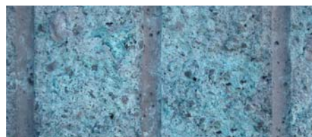
Profilert overflate som er hugget etter herding, her har man brukt hvit sement og blå fargepigmenter.
