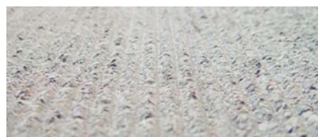
Profilert overflate hvor rillene er hugget etter herding.
