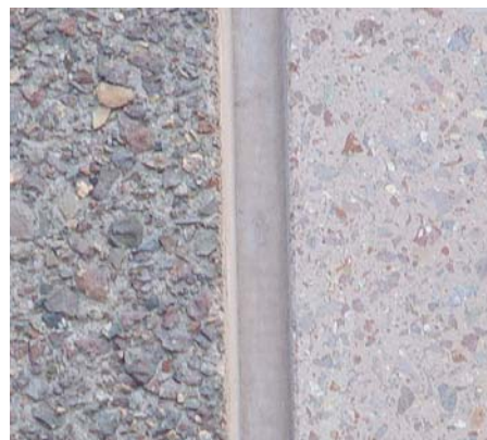
Frilagt overflate med overgang til mattslipt.
