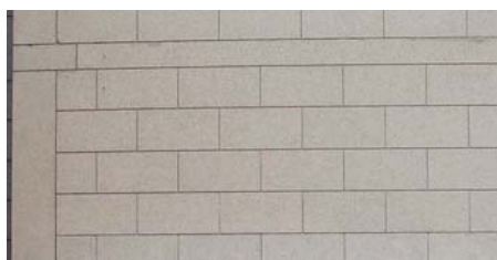
Overflatene er først rilleprofilert og deretter sandblåst. Her har man også valgt å rute opp en større flate.
