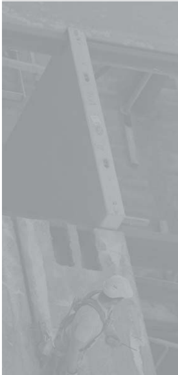
Figur 13 Opplegg av valset bjelke på stålsøyle.
