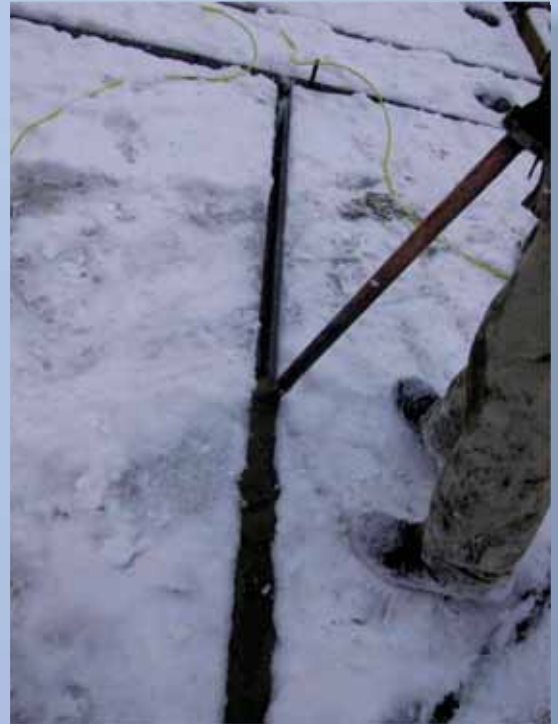
Hulldekkene skal rengjøres før fugging.
