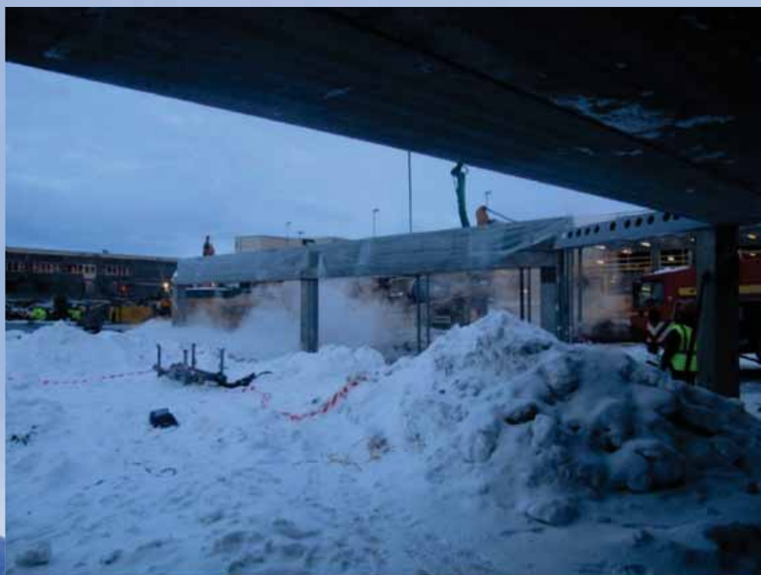
Plastfolie er god beskyttelse mot snø og is.
